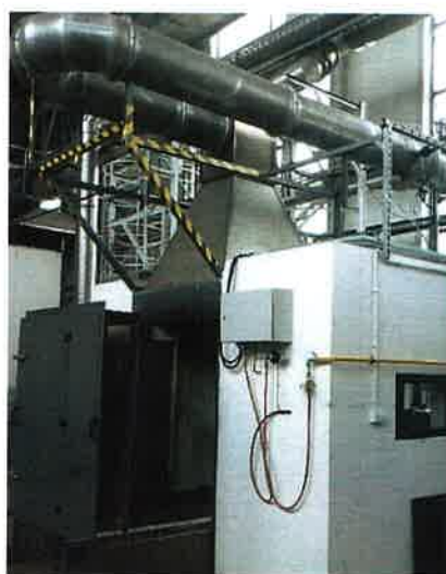
Fot. 3. Widok na stanowisko do badania reakcji na ogień wyrobów budowlanych poddanych oddziaływaniu termicznemu pojedynczego płonącego przedmiotu zgodnie z PN-EN 13823:2020-11, wykorzystywane w CNBOP-PIB
